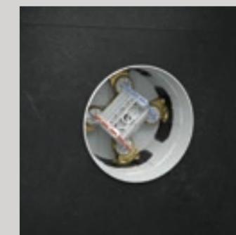
3. Sciacquare i tubi utilizzando il dispositivo di scarico pre-assemblato.
