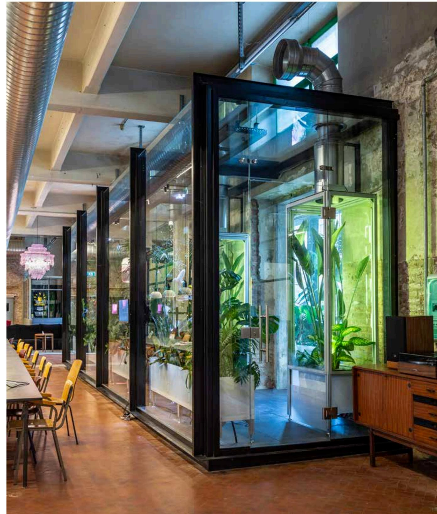
Sopra. Un altro scorcio del primo prototipo realizzato alla Manifattura Tabacchi di Firenze. La Fabbrica dell'Aria richiede poca manutenzione, l'irrigazione è automatizzata e la luce tecnica presente all'interno ha le frequenze specifiche per favorire la fotosintesi.
